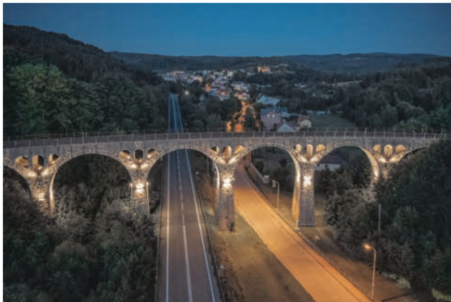
Fotografia 1. Wiadukt kolejowy w gminie Lewin Kłodzki, zbudowany w 1905 roku
