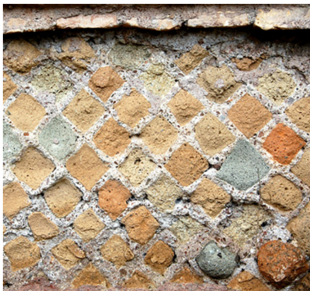
Fig. 4. Lopus reticulatum , nel muro del mausoleo c. d. dei Valeri, Roma, via Latina, II secolo (foto dell’autrice).
