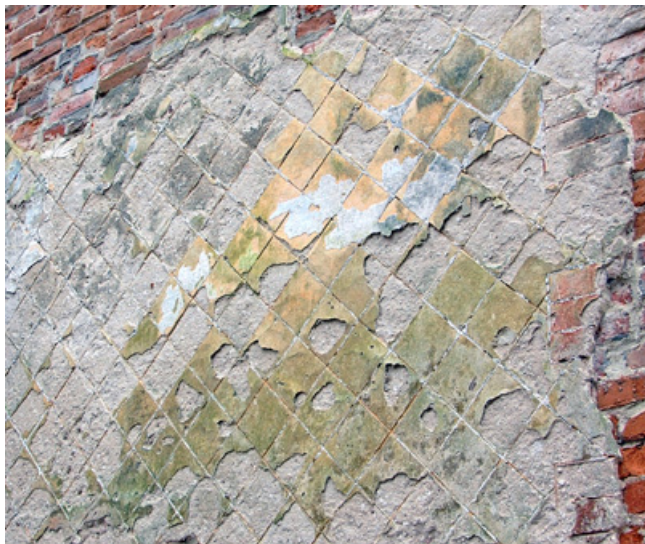
Fig. 3. “ Lopus reticulatum ” sulla c. d. Torre di Morysin, metà dell’Ottocento (foto dell’autrice).
