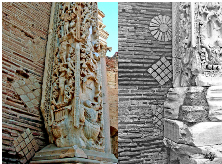
Fig. 10. e 11. Pannelli di opus reticulatum nella Basilica Severiana, Leptis Magna, inizio del III secolo, Libia (foto dell’autrice e secondo Wilson 2003, fig. 6).
