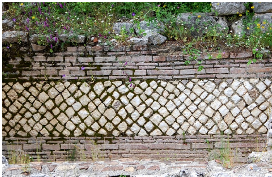
Fig. 7. Muro difensivo di Butrinto, I secolo a. C., Albania (foto dell'autrice).
