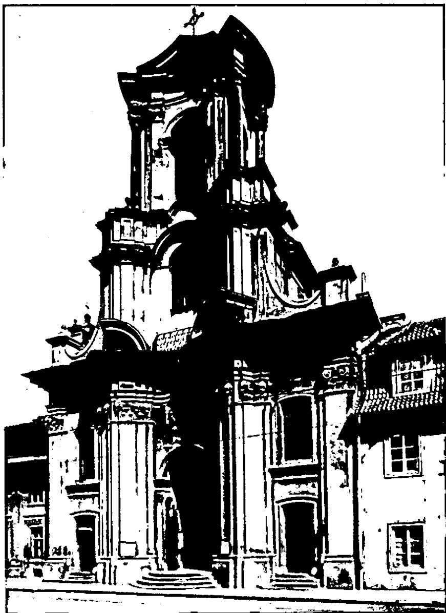
73. Cracovia, ex chiesa dei Trinitari (ora Fatebenefratelli), 1752-1756, arch. Francesco Placidi, facciata. Foto J. Langda. neg. IS PAN
