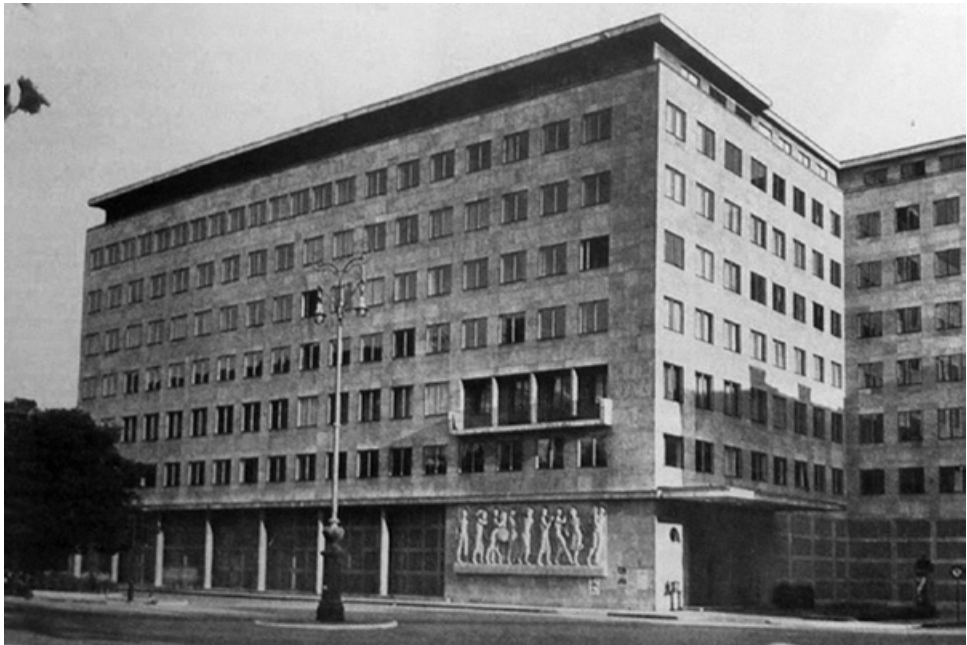
Budapest, Centro di Istituto Finanziario (oggi banca Unicredit), 1938-40, architetti: László Lauber, István Nyíri. Fot. Archivio „Tér és Forma”
