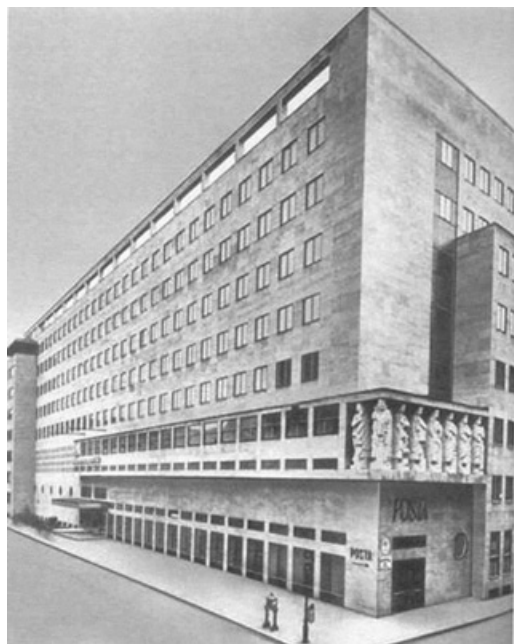
Budapest, Direzione delle Poste Ungheresi, 1939, architetto: Gyula Rimanóczy. Fot. Archivio „Tér és Forma”
